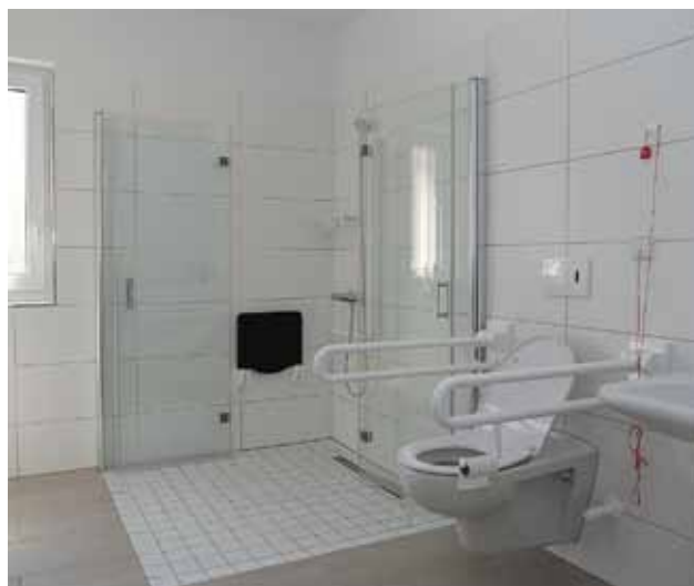
Neu geschaffene barrierefreie Sanitäranlagen.
